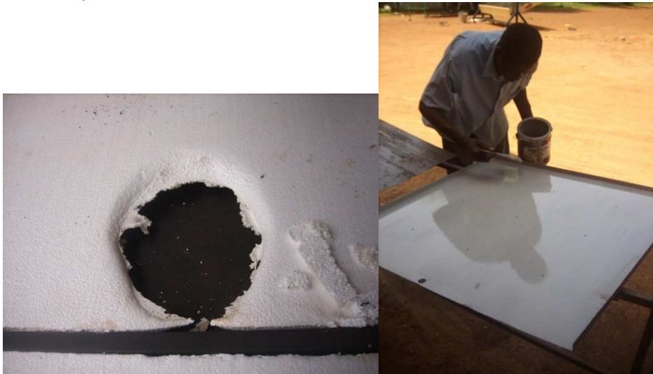
Figure 1- Trou dans l'isolation (gauche), peinture de l'absorbeur
