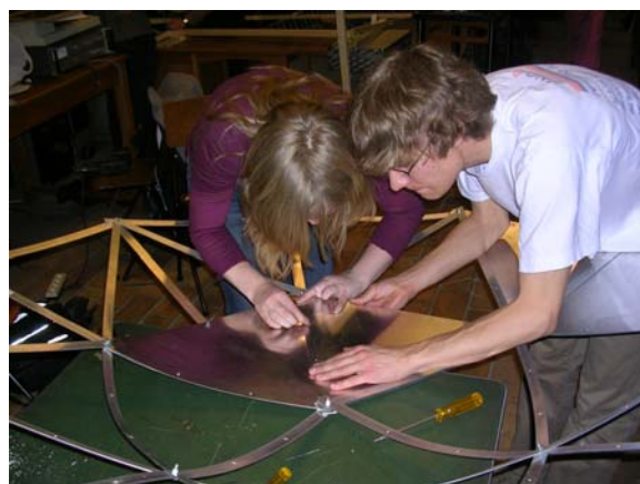
Figure 30 : Mise en place des plaques en aluminium sur la structure au moyen de boulons
