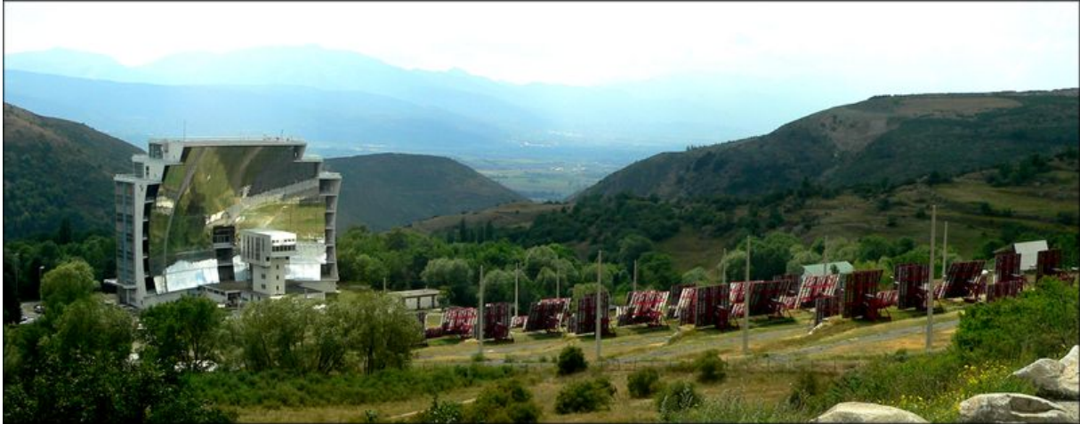
Figure 1 : Le four solaire d'Odeillo. A gauche, le miroir parabolique qui concentre les rayons du soleil. A droite, les 63 héliostats qui réfléchissent les rayons vers le miroir parabolique
